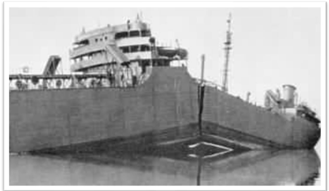
DWT 11000. Liberty Ships. Rotura frágil por falta de tenacidad en la soldadura
